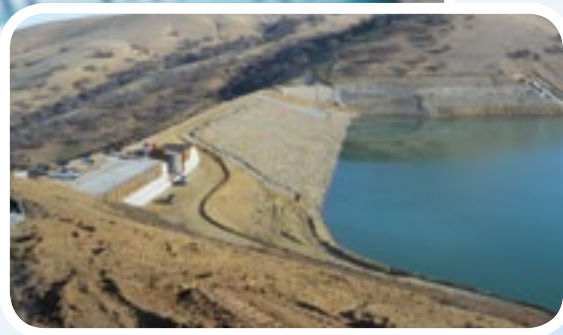
Los Vaqueros Expansion construction
